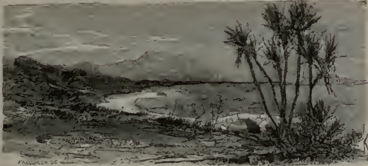
PONT SUR L'HARRACH (DAUZATS).
